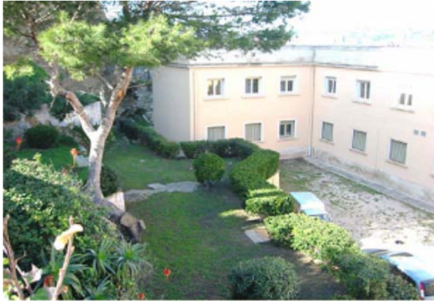
Imagen actual del edificio de la Administración de la Agencia Tributaria de Mahón (Menorca).
