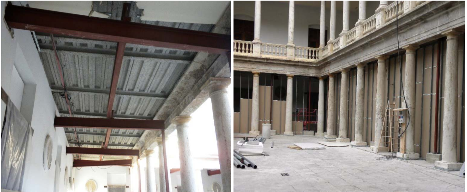
Estado de los trabajos que Cleop está realizando en el centro universitario La Nau de Valencia.
