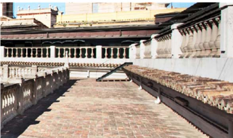
El final de los trabajos en la cubierta de La Nau está previsto para el mes de junio.
