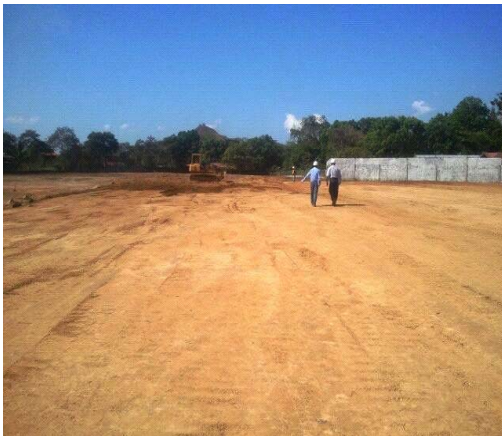
“Con la parcela ya limpia, se ha comenzado a trabajar en la zona del edificio principal. Se está realizando la ejecución de la subrasante del edificio para una vez alcanzada comenzar a abrir zapatas y vigas sísmicas, y también se ha comenzado a realizar el cajeo de las calles de la urbanización, con el fin de extraer material adecuado para los rellenos”, explica Juan Mena sobre el terreno.
