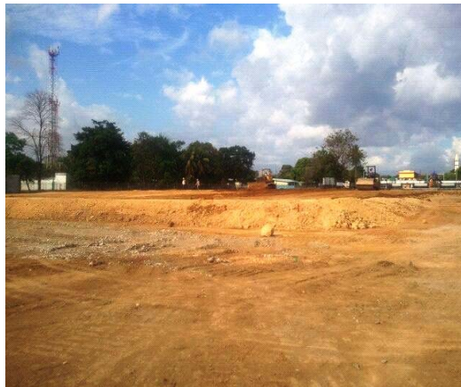
“Con la parcela ya limpia, se ha comenzado a trabajar en la zona del edificio principal. Se está realizando la ejecución de la subrasante del edificio para una vez alcanzada comenzar a abrir zapatas y vigas sísmicas, y también se ha comenzado a realizar el cajeo de las calles de la urbanización, con el fin de extraer material adecuado para los rellenos”, explica Juan Mena sobre el terreno.
